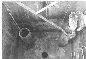
写真3 脱離液ピット調査時状況
