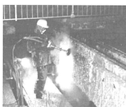
写真2 超高圧水処理作業
