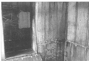
写真2 特殊マンホール調査時状況
