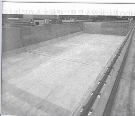
施工完了写真
