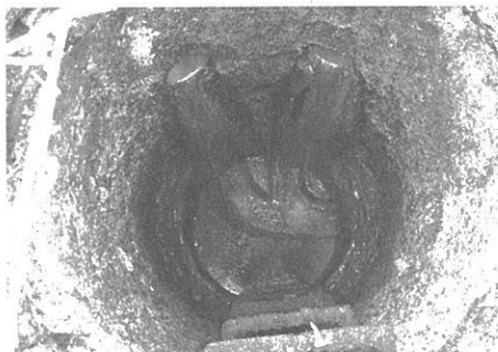
写真-1 施工前状況
