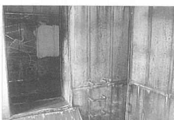
写真2 特殊マンホール調査時状況
