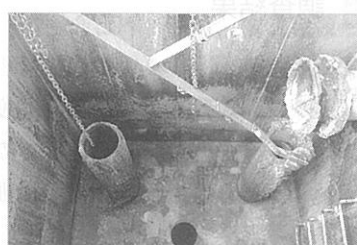
写真3 脱離液ピット調査時状況
