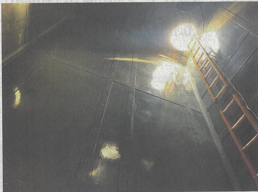
施工完了の様子
