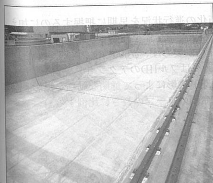
施工完了写真
